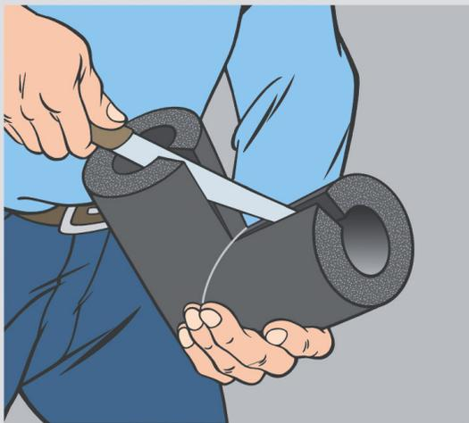
**4** После того, как клей просохнет, аккуратно прорежьте изоляционный угол вдоль внутренней стороны.
